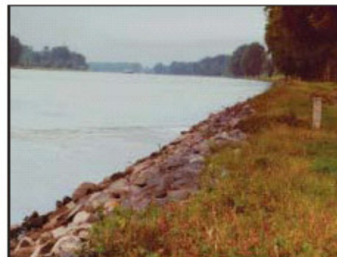
Abb.5: Uferbefestigung als Folge der Schifffahrt
